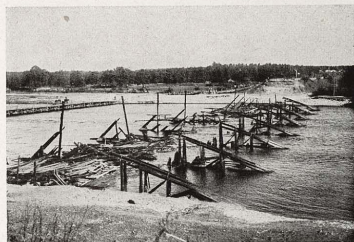
Die von den Russen zerstörte Holzbrücke über die Aa
