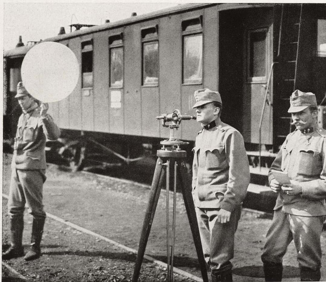
Mittel, um Windrichtung und Windstärke festzustellen
