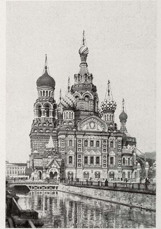
Die Auferstehungskirche Phot. Techno Phot.-Archiv
