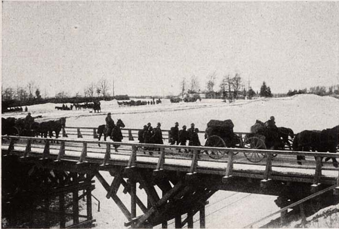
Übergang über die Bahn Riga—Petersburg
